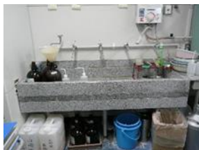
写真①: 洗浄施設（実験用流し）及び附帯配管等
