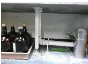
写真①: 洗浄施設（実験用流し）及び附帯配管等
