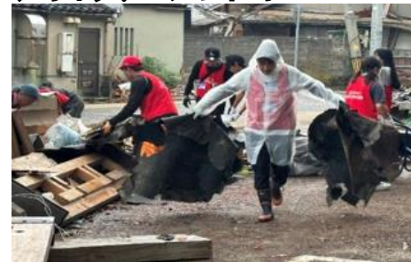
大雨の中瓦礫を搬出
