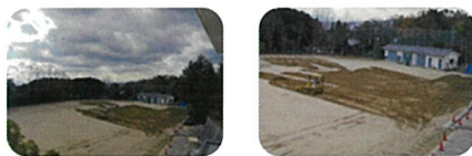
2年前の整地の様子。3日間の工事でした!(附中の小窓より)
