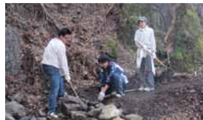
第2回道普請にて。崩壊した道の修復
