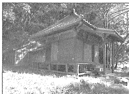
宮城県七ヶ浜町湊浜薬師堂と覆屋
