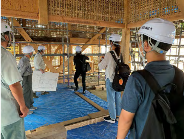
復旧作業中の主屋での説明
