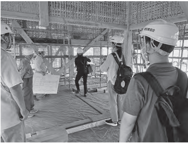
復旧作業中の主屋での説明
