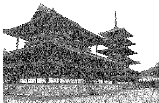
法隆寺金堂と五重塔
